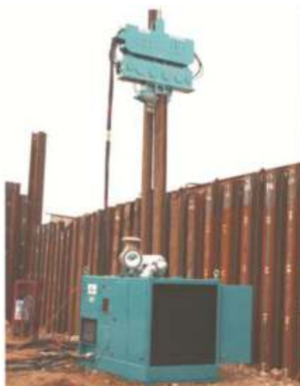
香港施工工地 working in hongkong
