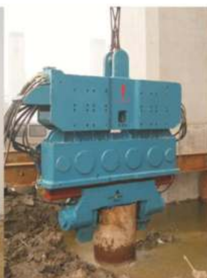
香港施工工地 working in hongkong
